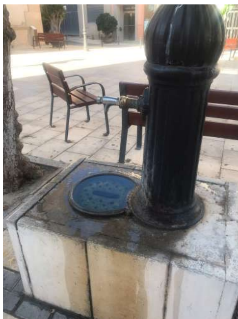
Figura 14. Modelo de fuente de piedra, en su mayoría en mal estado. Figura 15. Fuente de hierro fundido con agua estancada en su sumidero
